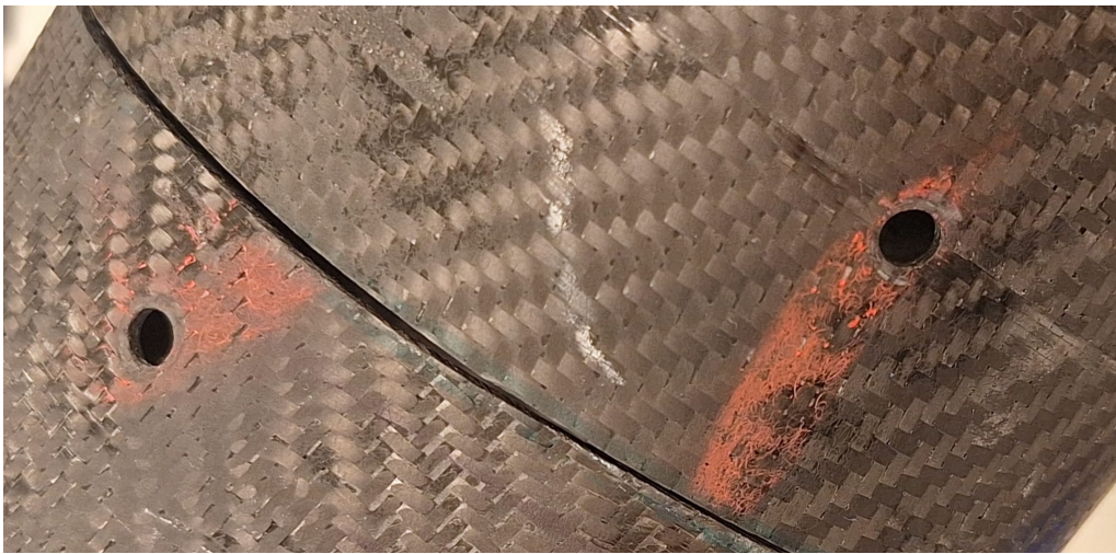
FIGURE 2.22 – Perçages au niveau du système de séparation
