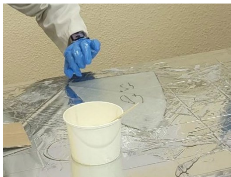
Figure 31 : Préparation d'une couche en fibre de verre
