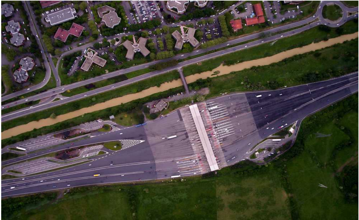
Le péage du Sud Est de Toulouse
