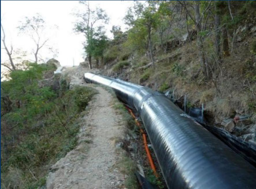
Les conduites forcer sont de gros tuyaux, qui emmenent l'eau dans le bâtiment que l'on a vu dans la photo précédente.
